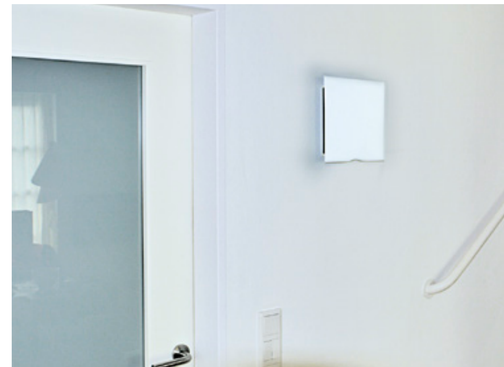
Поруч з дверима знаходиться непримітний перетічний елемент, який містить інтегрований вентилятор для подачі повітря в сусідню кімнату.
