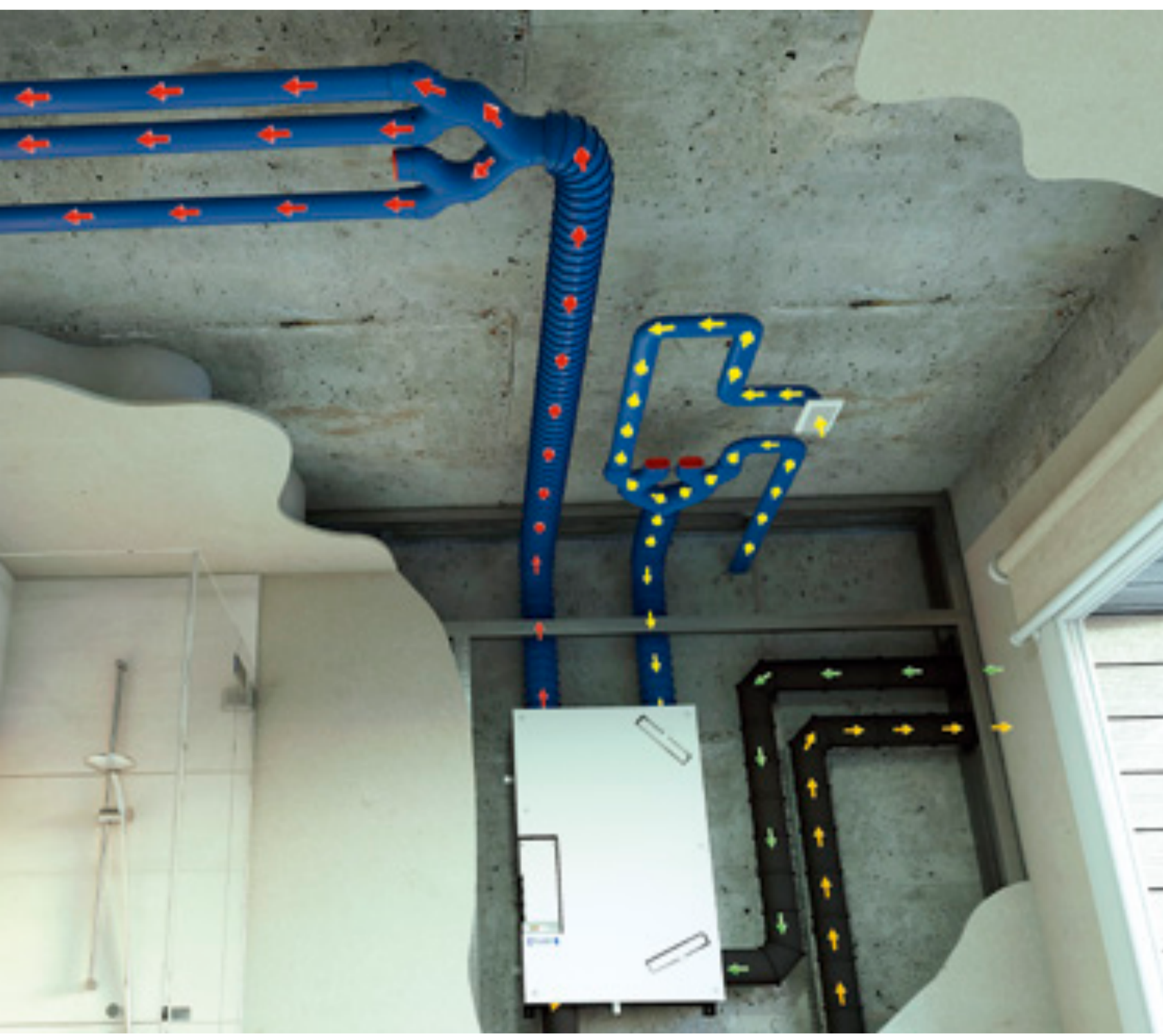
Вентиляційний блок над туалетом і система розподілу під стелею під ванної кімнати - без втрати простору
