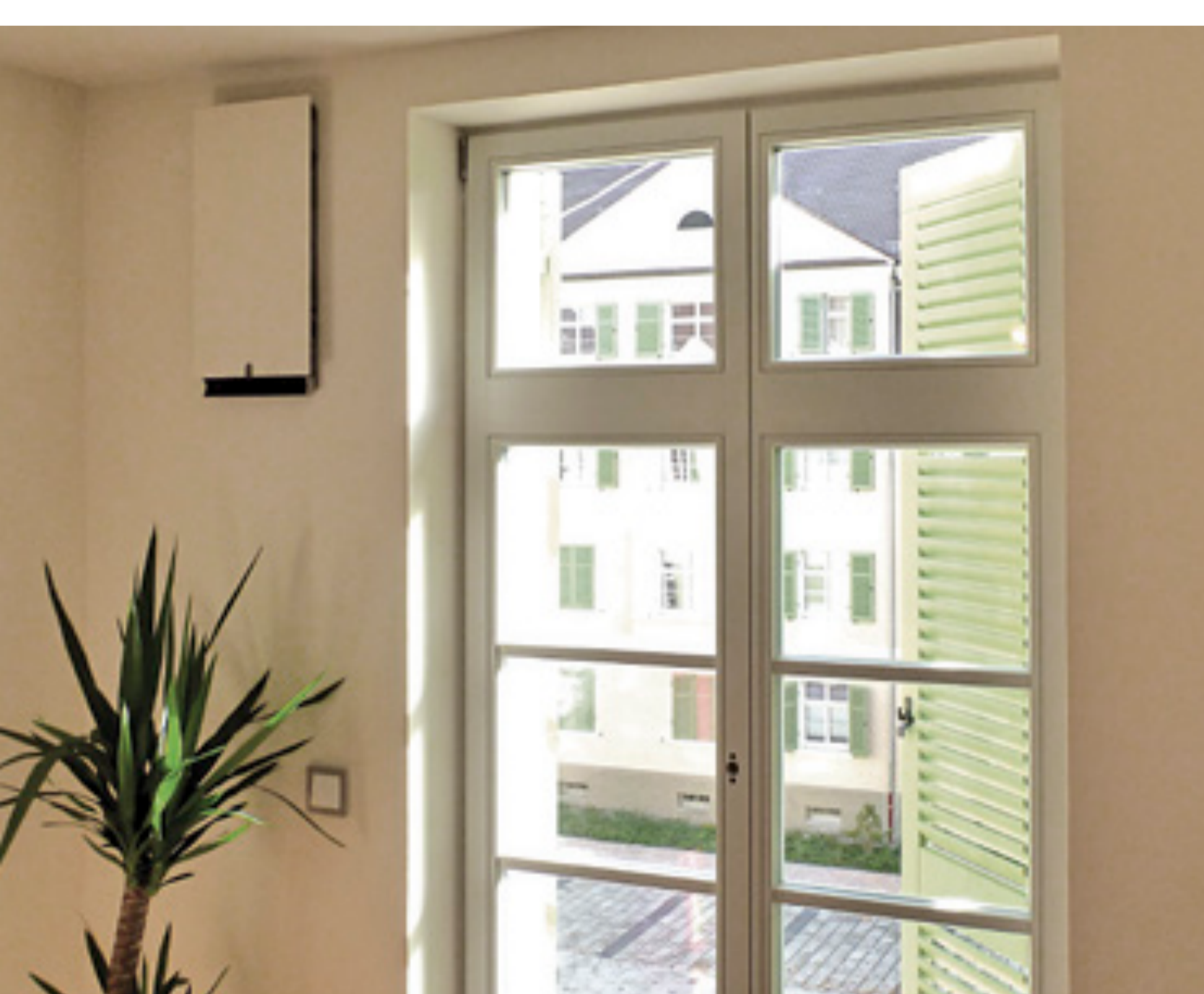
Вбудований вентиляційний блок
