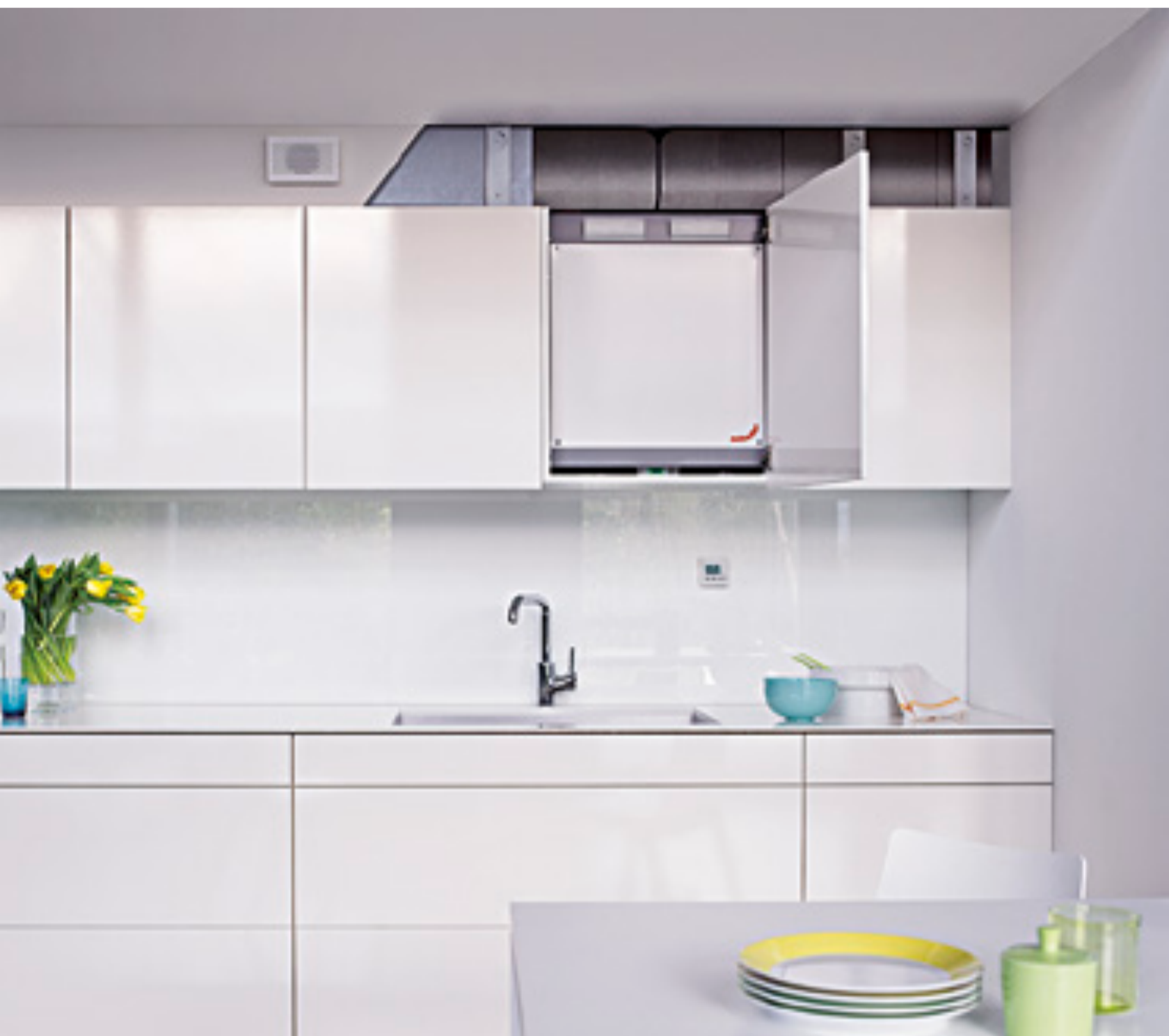
Вентиляційна установка інтегрована в кухонні меблі
