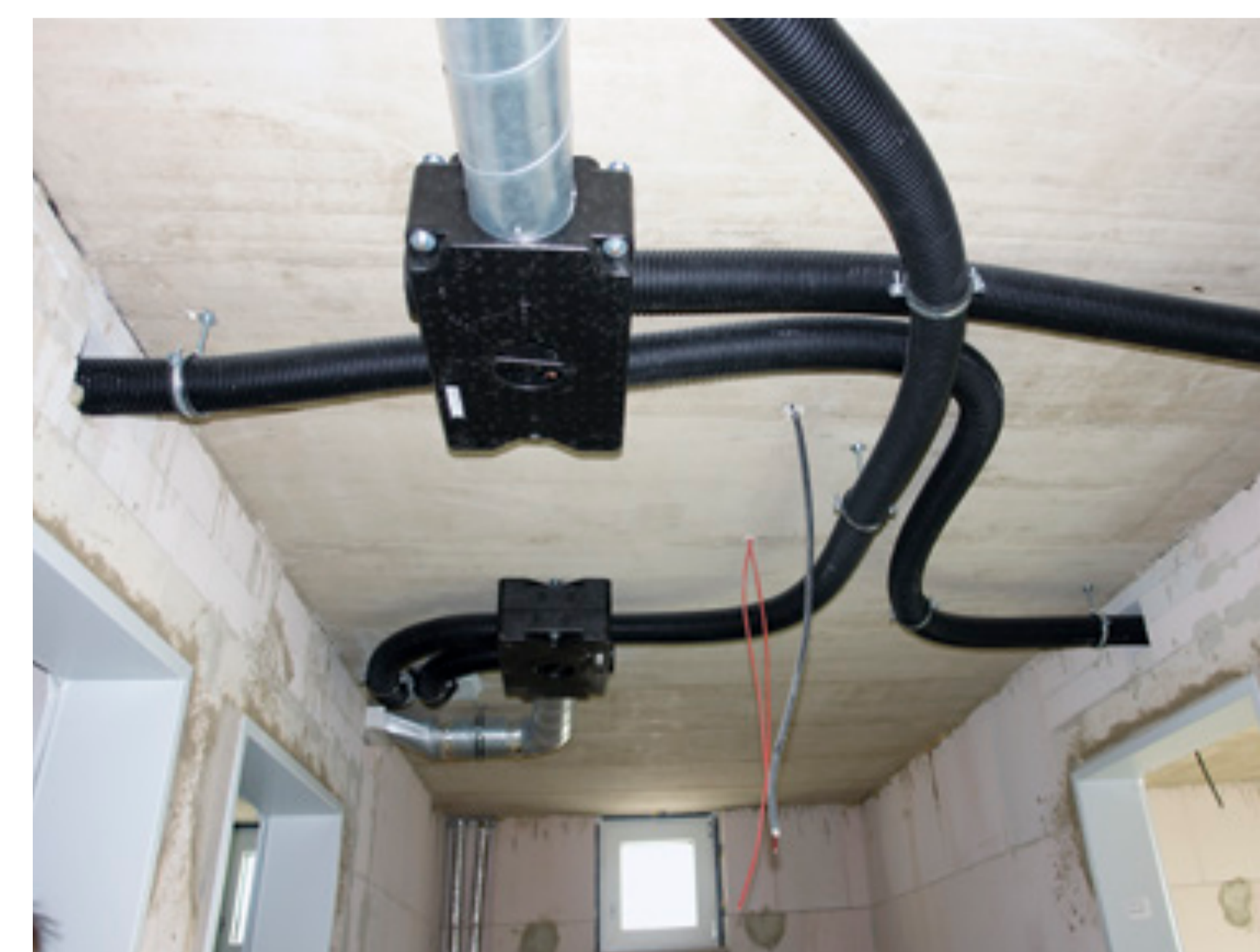
Розподі в формі зірки через шумопоглинаючі розподільчі бокси
