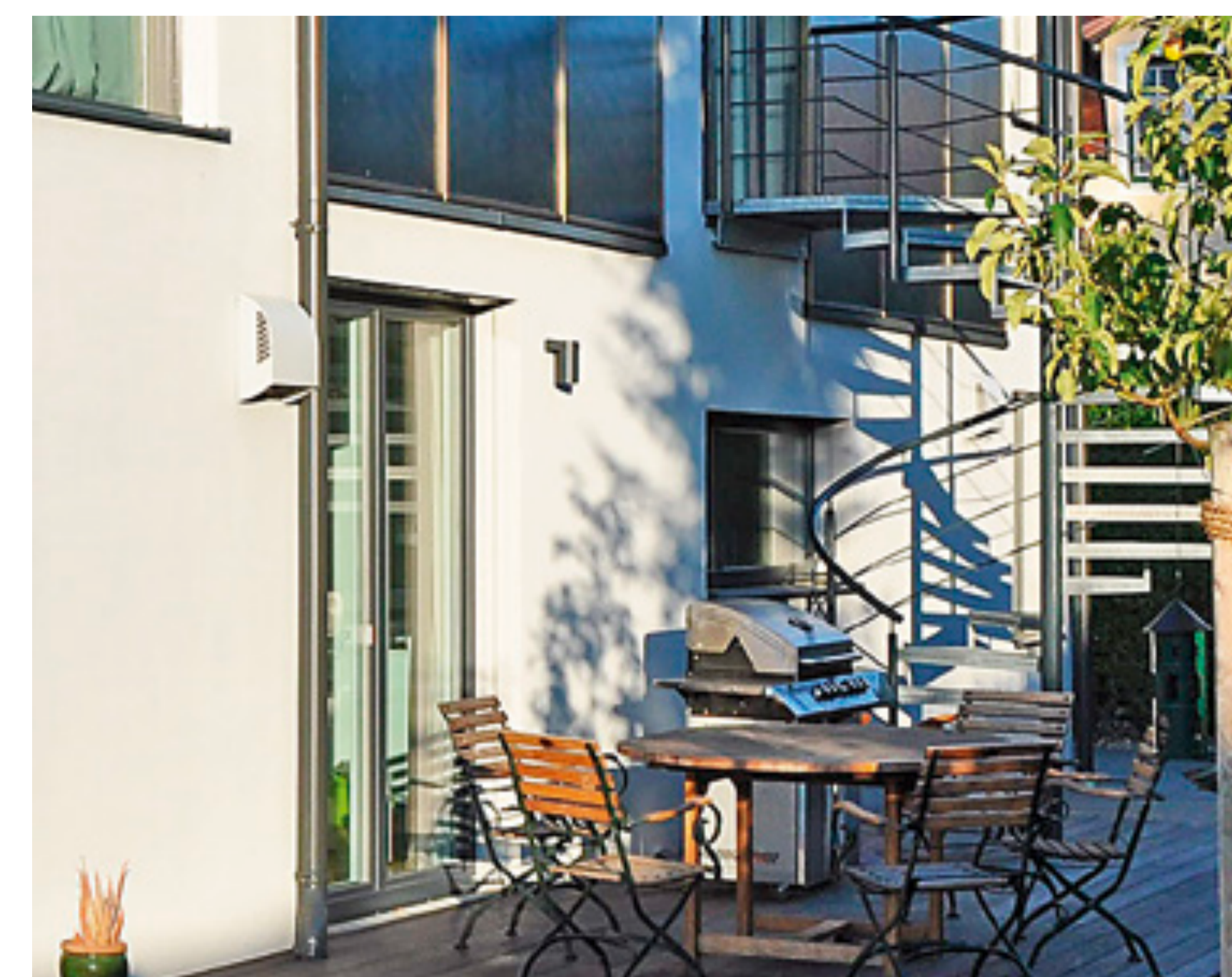
Фасадний елемент забору/подачі повітря
