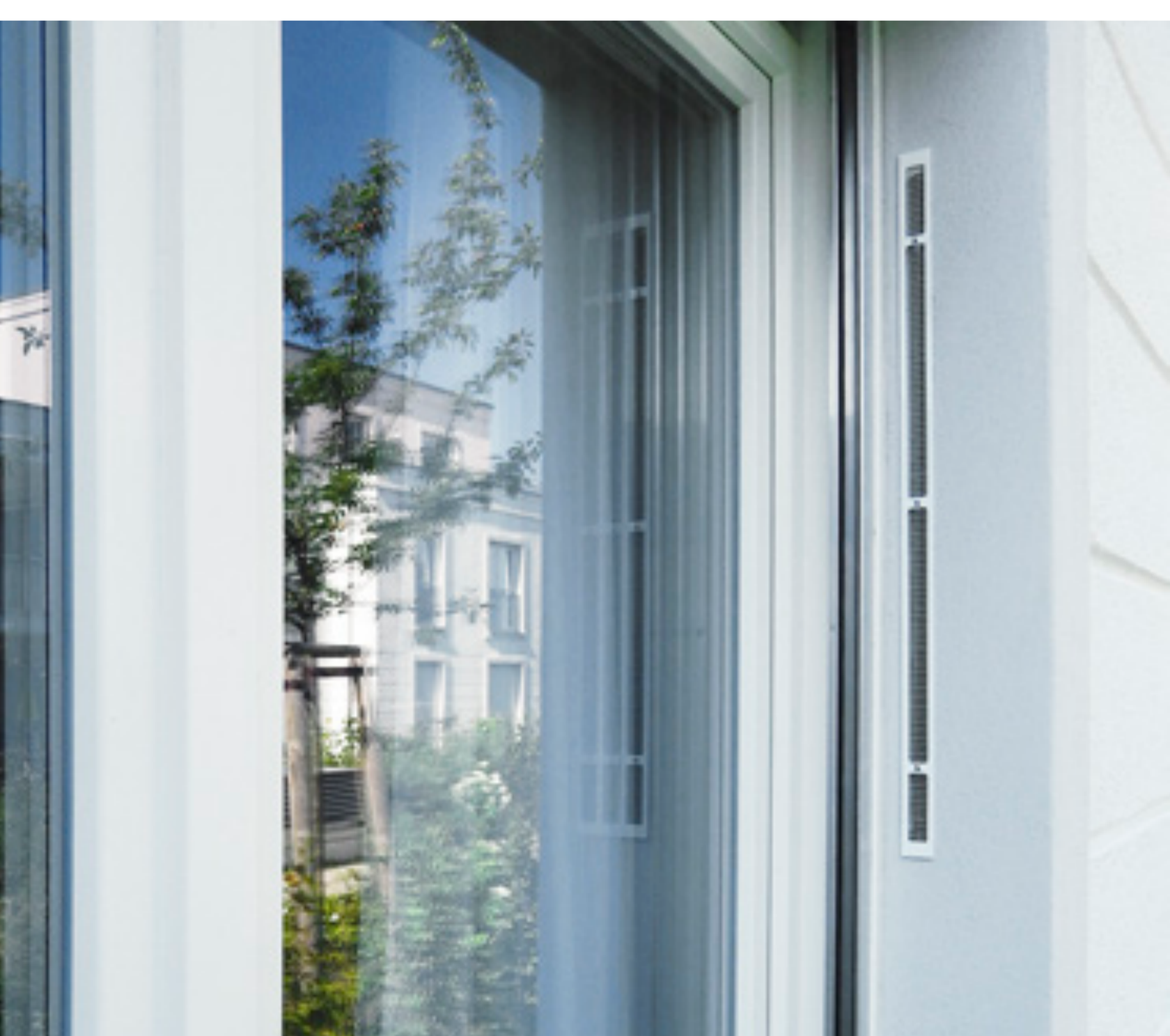
Чудове рішення: елемент забору повітря в віконному відкосі
